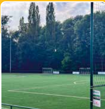
Heraanleg voetbalsite met kunstgrasveld
