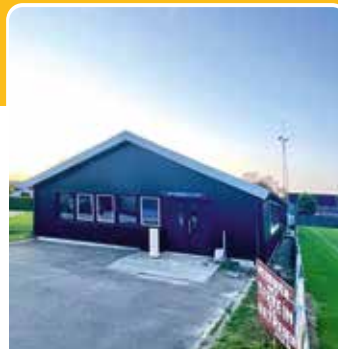
Vernieuwing voetbalkantine en aanleg speelplein
