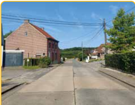
Heraanleg Meenselstraat en Binkomstraat
