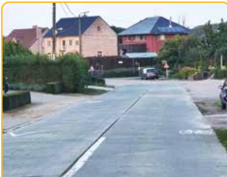
Aanleg fietspad Helstraat
