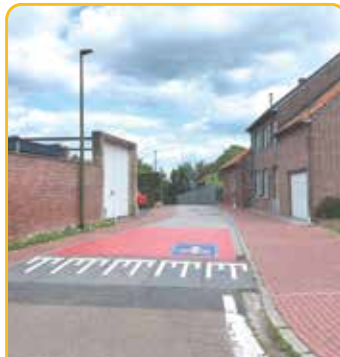
Wegenwerken: heraanleg Boutersemstraat en Schoolstraat
