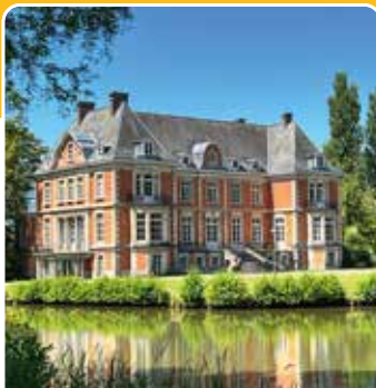
Bouw nieuwe school en bescherming en renovatie Kasteel de Maurissens
