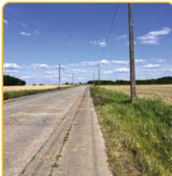
Grondige heraanleg fietspad Lostraat
