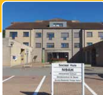
Opwaarderen dienstencentrum: renovatie serviceflats, muurschildering, mobiele kruidenier, opwaarderen keuken, Mamadepot
