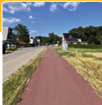
Aanleg fietspad Ganzendries, fietsstraat Fonteinstraat en uitbreiding zone 30 schoolomgeving
